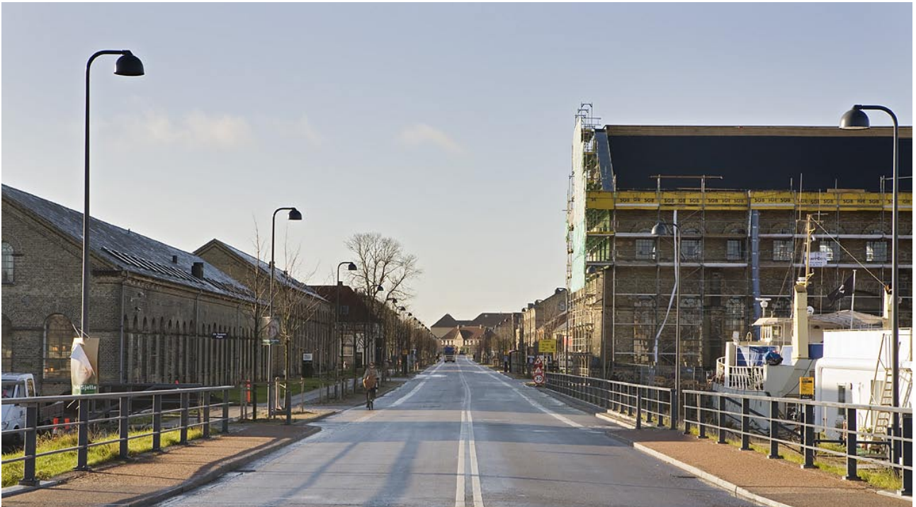
Danneskiold-Samsøes Allé set fra nord
