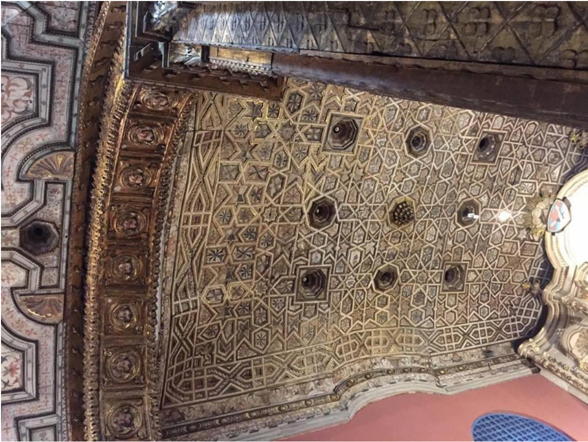
Fig. 1.16 Iglesia de la Concepción, Bogotá, Colombia. Source: by L. Barragán.
