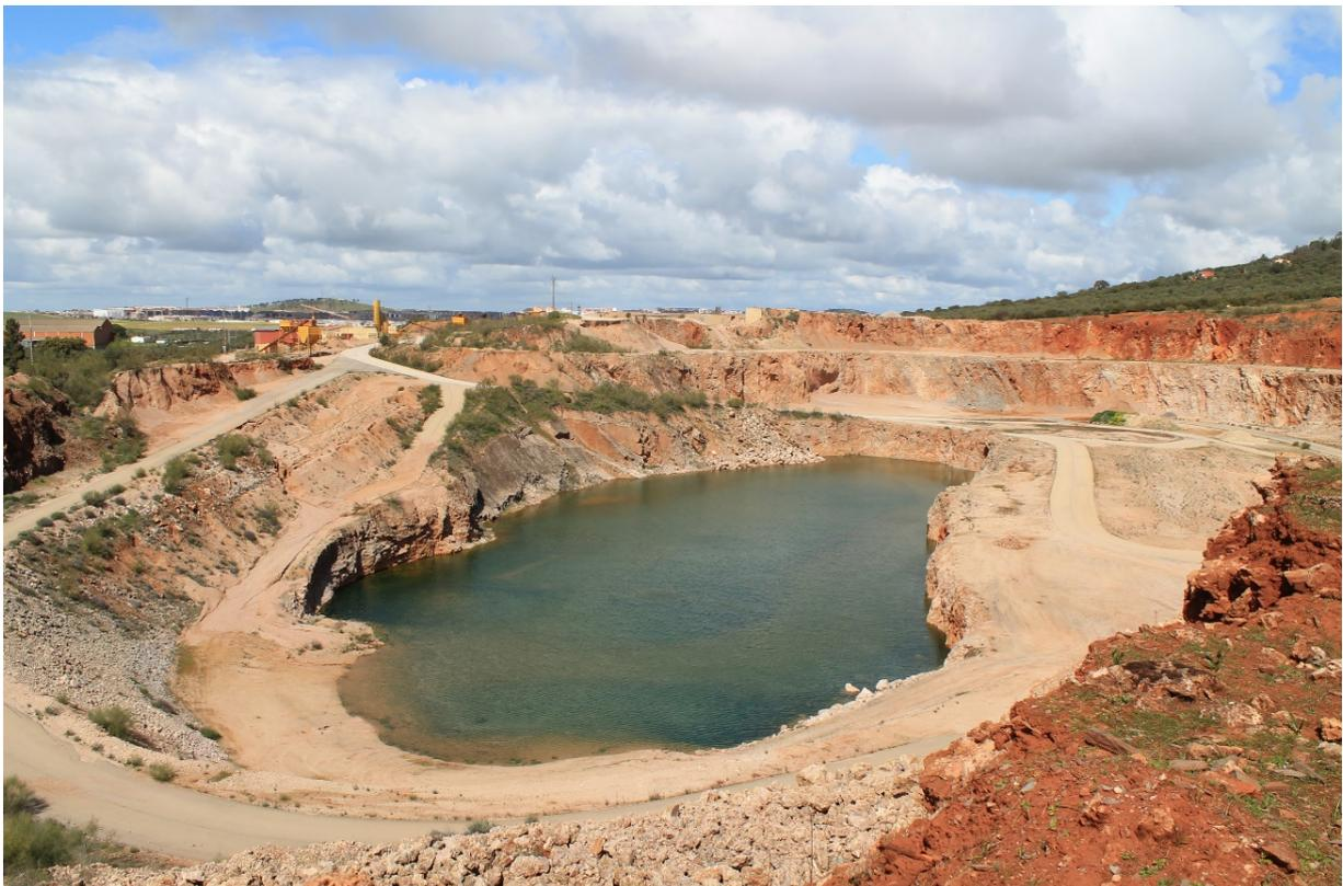
**Cantera de Olleta.** El agua subterránea aflora al haberse realizado la excavación por debajo del nivel freático.
