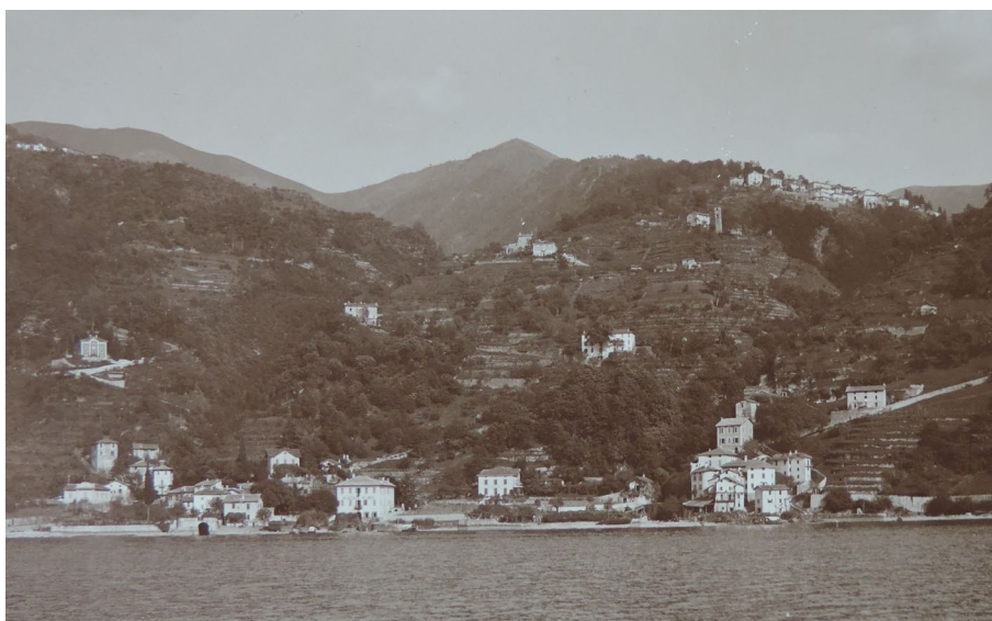
Figura 7. La stessa area della frana (a destra dell'unica casa sopravvissuta), a mezzo secolo di distanza circa (foto Brunner n. 2428, Biblioteca Comunale di Como, fondo Brunner)
