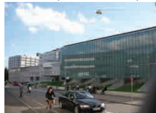
p Ampliació Hospital de Basilea
