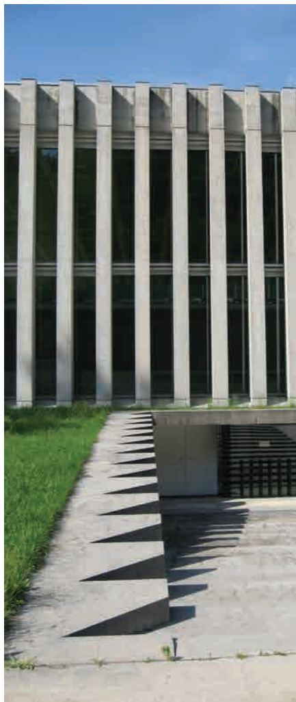
25 Detall de l'accés subterrani
