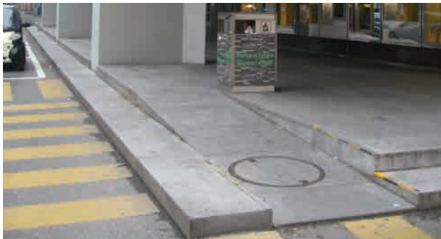
186 Adaptació puntual de rampa per a minusvàlids a la base de la Posta
