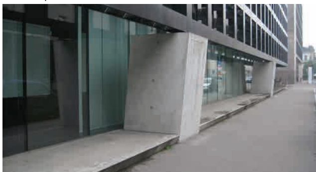
190 Graó perimetral en la Ferriera de Locarno
