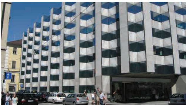
201 Verticalitat en la façana portant del Centre de Serveis de Locarno
