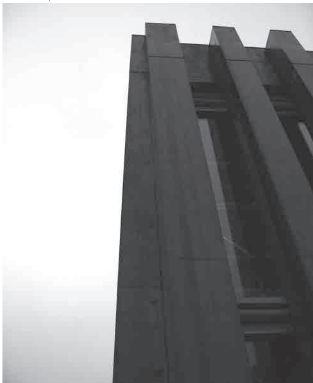
76 Vista superior de la cantonada de la Palestra de Losone
