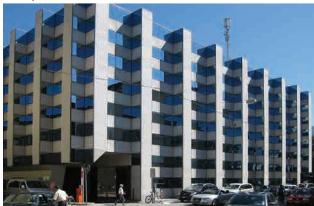
127 Aspecte monumental de la Posta de Locarno
