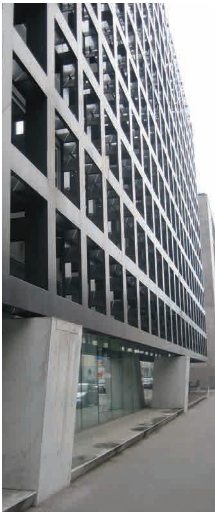
31 Detall dels suports de formigó
