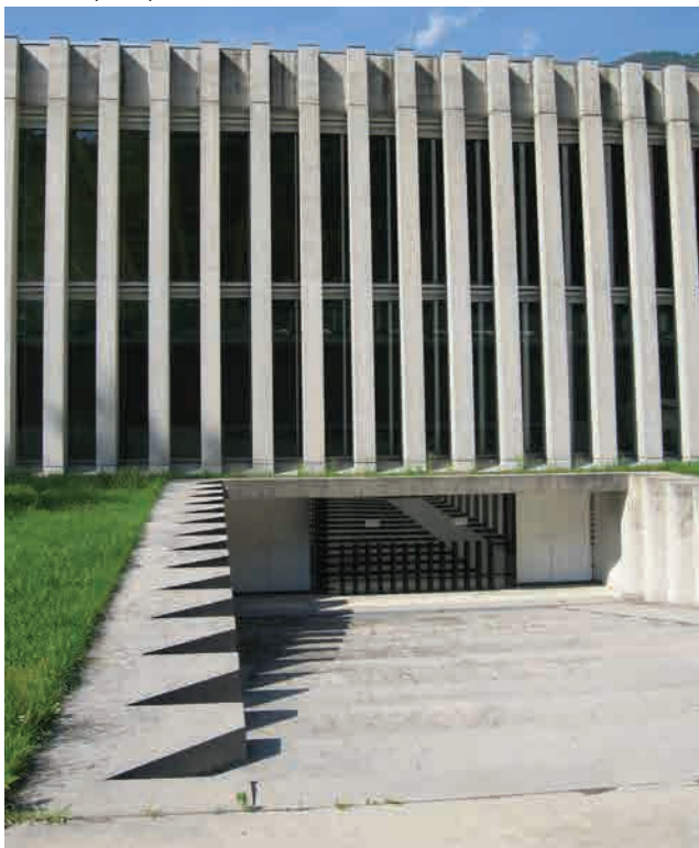
49 Subtil entalladura a l'arranc de les columnes.
