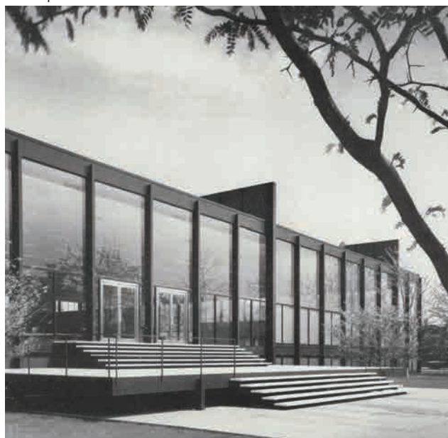
110 Aspecte de l'estructura del Crown hall de la I.I.T. de Mies van der Rohe
