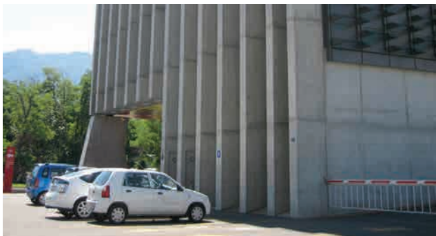
187 Entrega dels pilars al terra en el Centre de Serveis de Locarno
