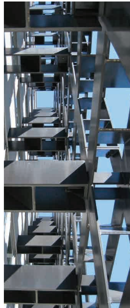
33 Detall de la gàbia metàl·lica exterior
