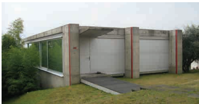
210 El sostre enretirat en la Casa a Costa
