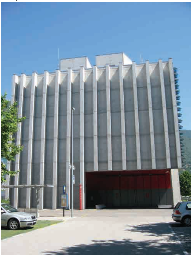
59 Façana a carrer del Centre de Serveis de Locarno
