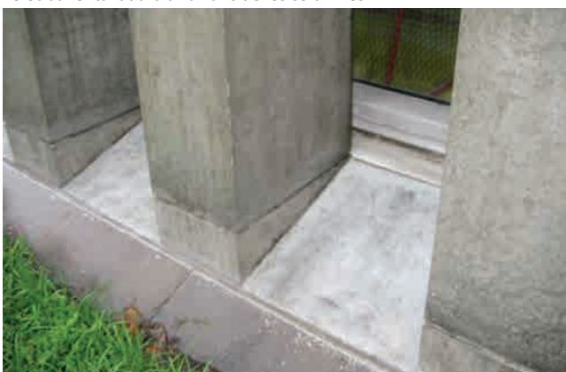
49 Subtil entalladura a l'arranc de les columnes.
