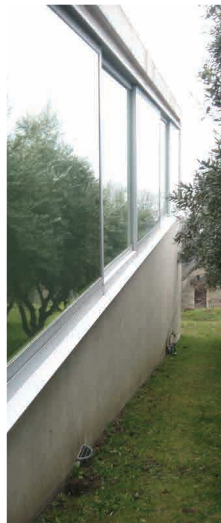
15 Detall de la façana lateral
