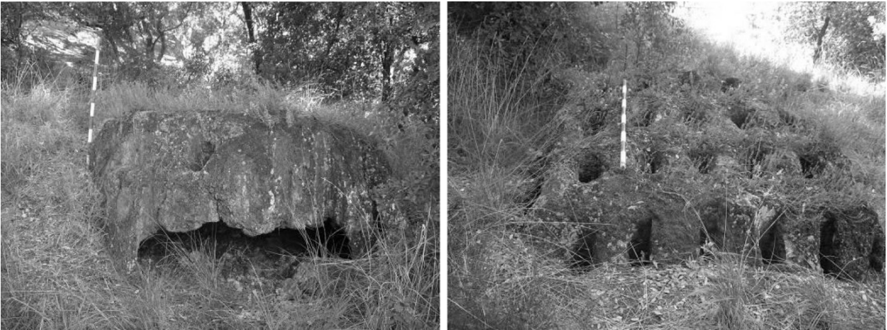
Figura 117: Vista frontal i de la graella del forn de Can Pericas (L. 24).
