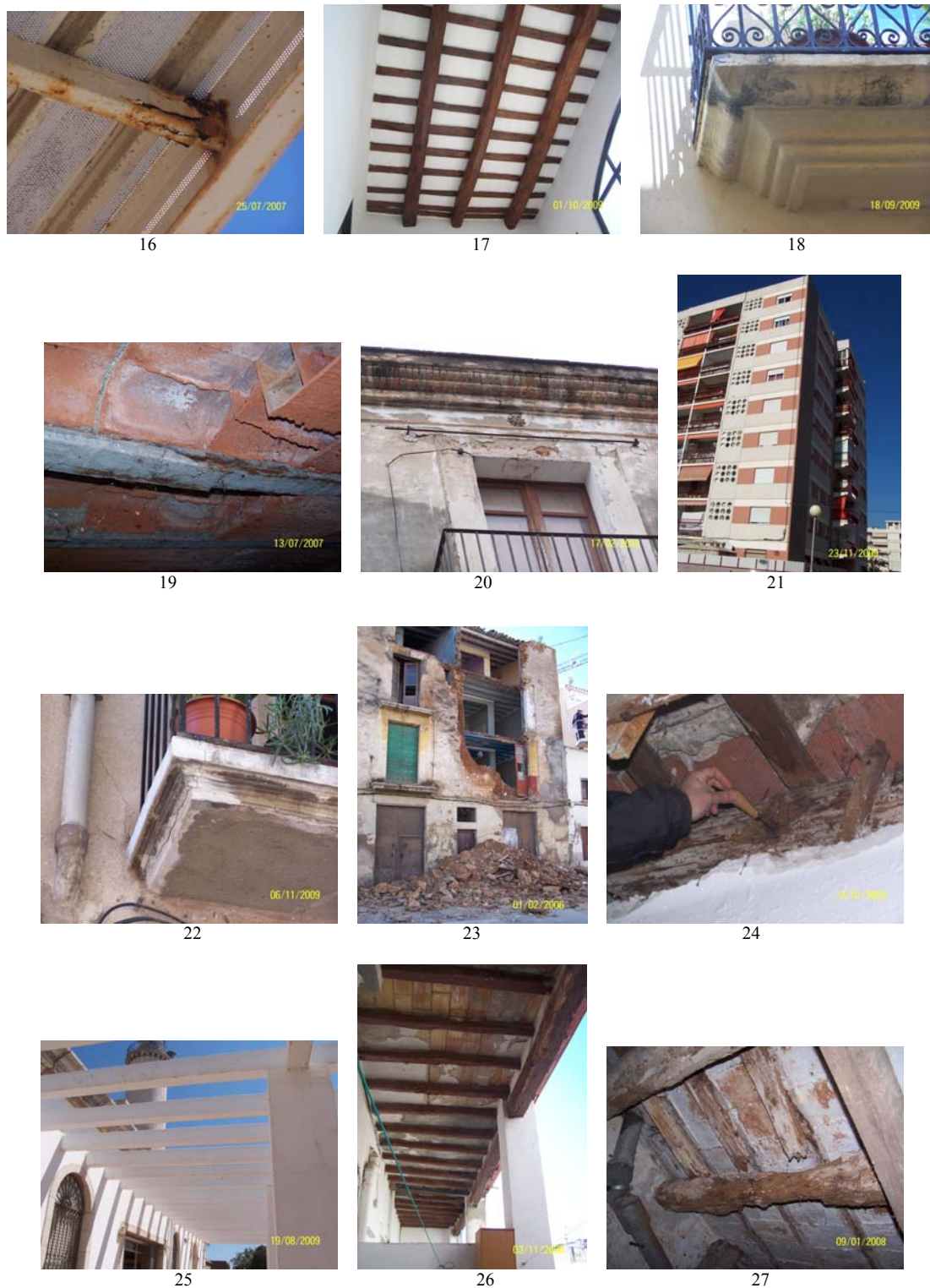
Figura 5.2 (Cont.). Imágenes de elementos constructivos que formaban parte del ensayo
