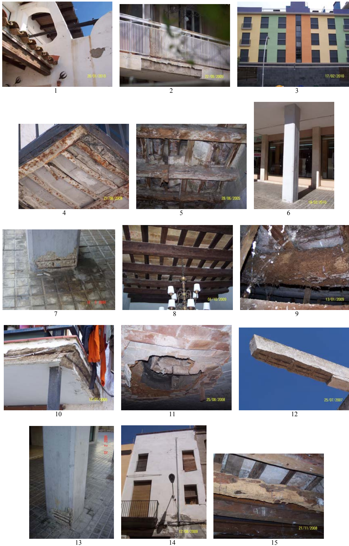
Figura 5.2. Imágenes de elementos constructivos que formaban parte del ensayo
