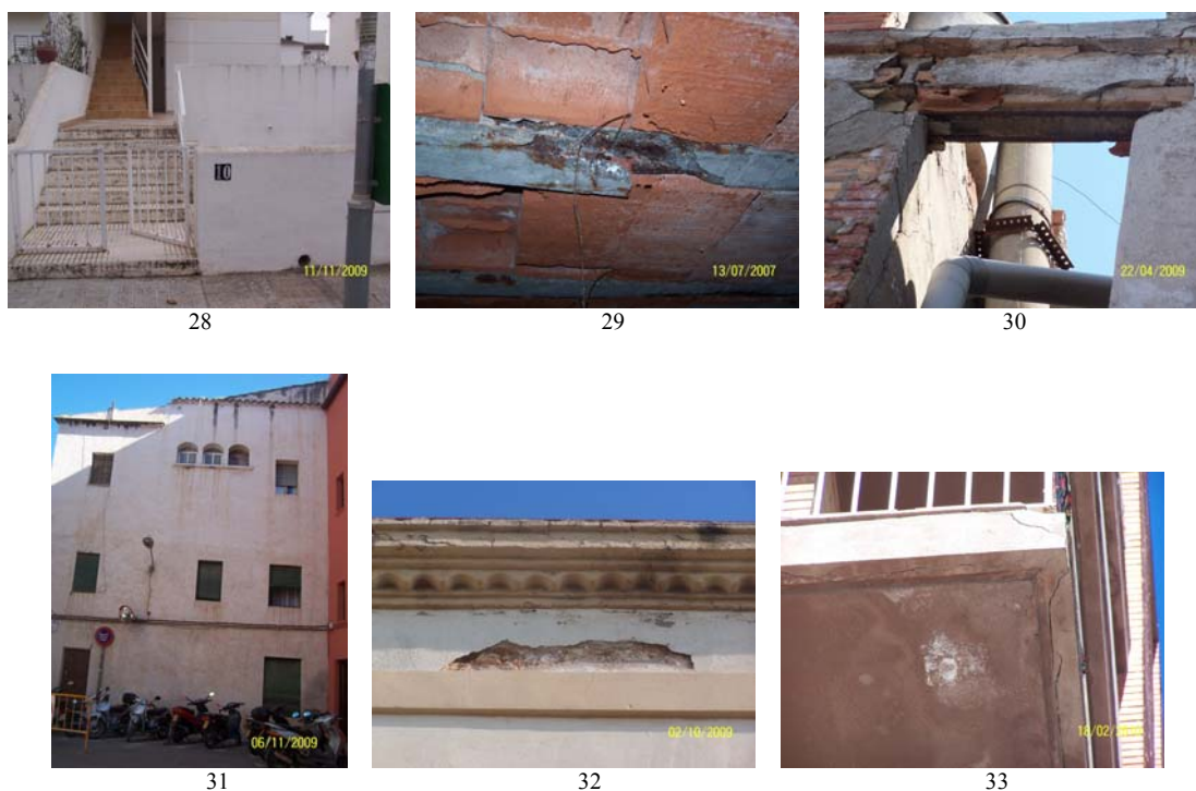
Figura 5.2 (Cont.). Imágenes de elementos constructivos que formaban parte del ensayo
