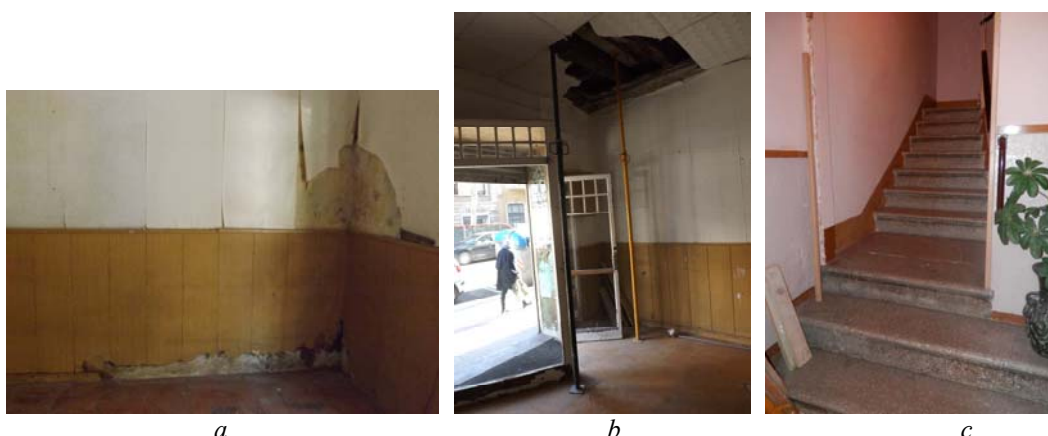
Figura 4.13. Vista en a de la medianera 1, a nivel de PB. Vistas en b y c de la medianera 2, a nivel de PB. En c además vista de la escalera comunitaria
