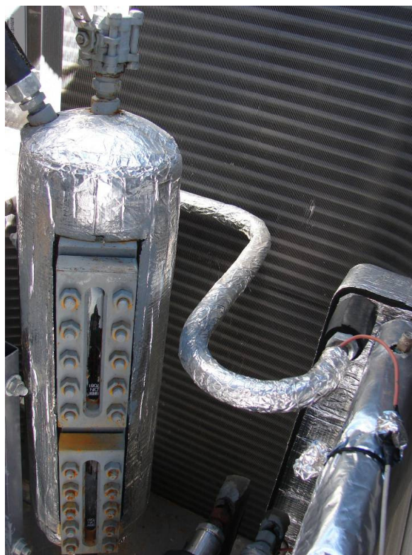
Figura 2-5: Depósito de solución pobre a la salida del generador
