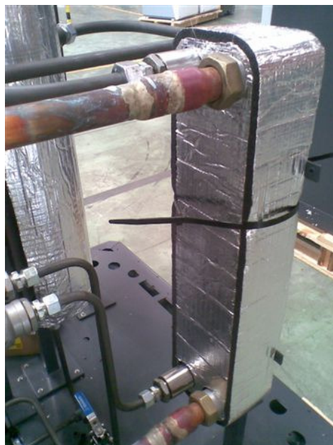
Figura 2-4: Intercambiador de placas generador
