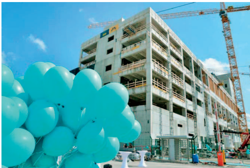
Sl.1 Gradilište 4. po redu Lenzingove tvornice za proizvodnju TENCELA®
