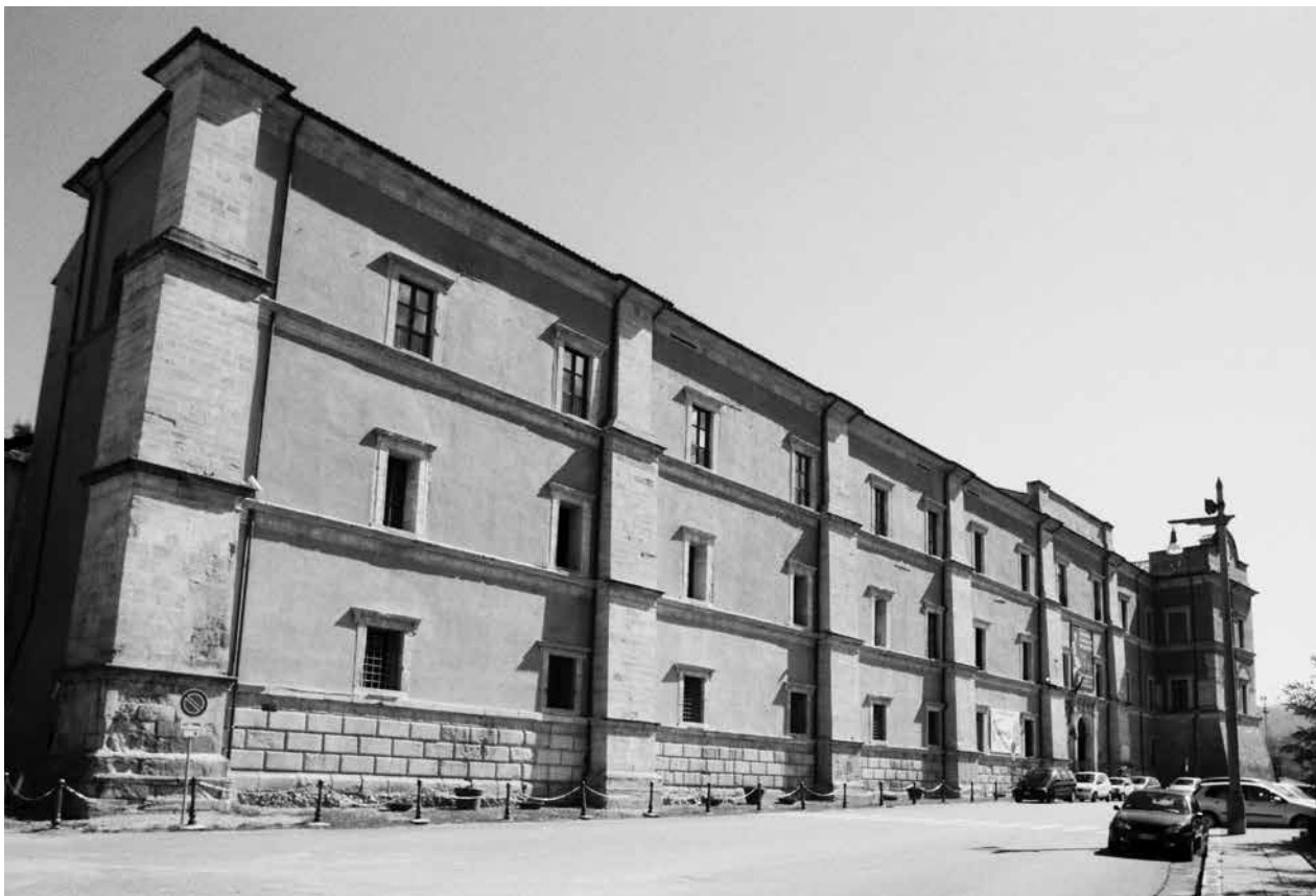
Cosenza, Palazzo Arnone, pročelje / Cosenza, Palazzo Arnone, main front
