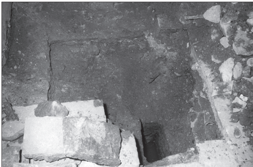
Slika 2. Sonda I.5.a - Vertikalni kanal pravokutnog presjeka u temeljnom zidu, pogled s istoka (Arhiv GN, 4338D)
