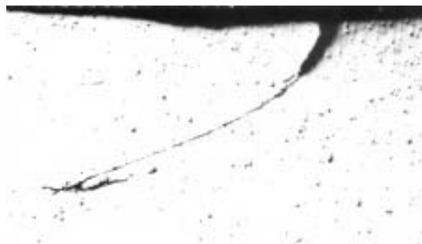
Slika 4. Pukotine na vanjskoj površini cijevi uzrokovane nečistoćama čelika Figure 4. Cracks on the external tube surface caused by steel impurities
