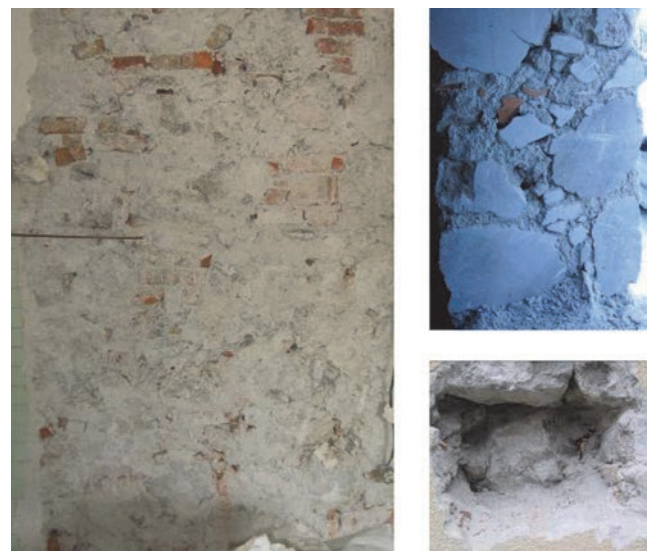
Slika 2. Tekstura (lijevo) i morfologija (desno) zidanih kamenih zidova
