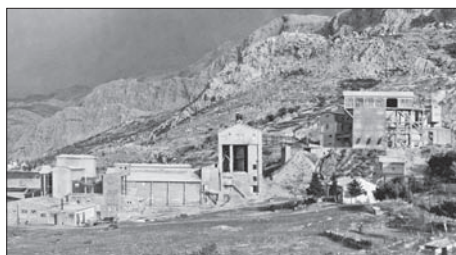
SL. 6. TVORNICA U RAVNICAMA NAKON DRUGOGA SVJETSKOG RATA: ZGRADA ZICARE (LIJEVO) I SILOSI SIROVINE FIG. 6. FACTORY IN RAVNICE AFTER WORLD WAR II: CABLE CAR BUILDING (LEFT) AND RAW MATERIAL SILOS
