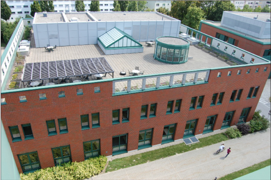
Abb. 1: Universitätsbibliothek der Veterinärmedizinischen Universität Wien, Bibliotheksgebäude (© UB Veterinärmedizinische Universität Wien)
