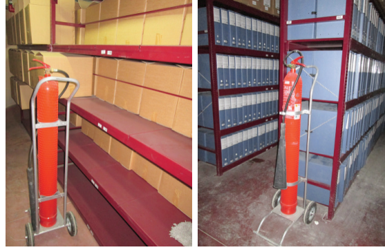
Şekil 7: Topkapı Arşiv Binası (solda) ve Merter Arşiv Binası (sağda) hareketli yangın söndürücüleri.
