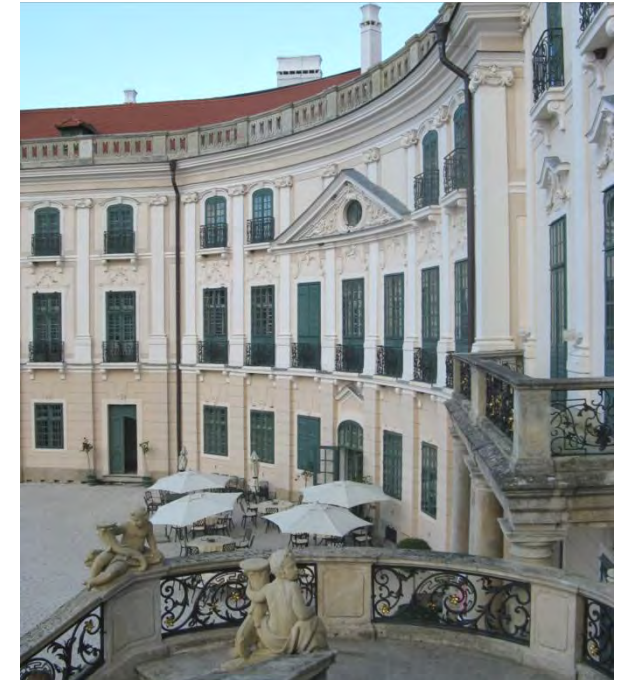
Fertőd-Eszterháza díszudvar felőli homlokzata a felújítás után, 2011-ben (Fotó: Mezős T.)
