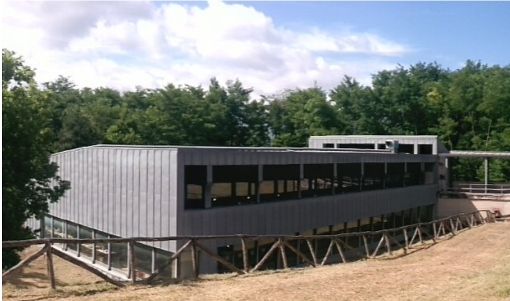
Fig. 47 - Isernia La Pineta. veduta esterna del padiglione che copre l'area di scavo (foto G. Lembo).
