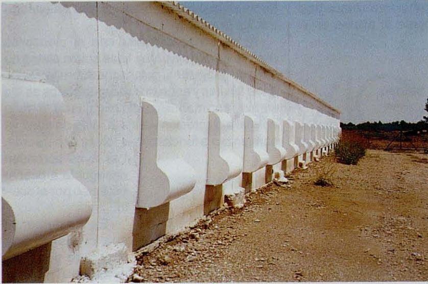
Detalle de las entradas de aire de una nave.
