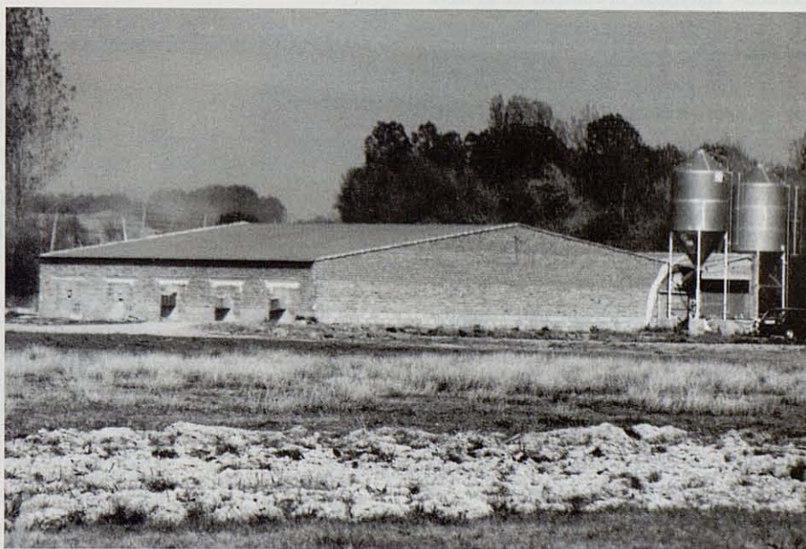
Nave de conejos construida con fábrica armada (sin estructura). Los tabiques interiores sirven de soporte de la cubierta (tejado). (Foto tomada en La Milla del Río (León)).
