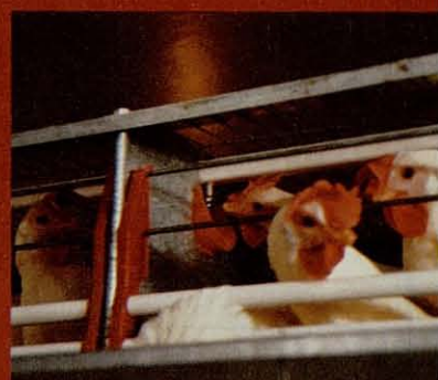
Vista frontal de una batería de ponedoras con puertas horizontales de plástico, bebederos de chupete de acero inoxidable y con tacho para eliminar la humedad producida por goteos, reduciendo la producción de amoníaco.
