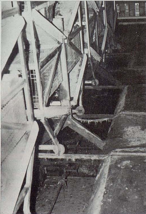
Figura 4. Los excrementos caen sobre una canal, la cual es evacuada automáticamente mediante un pequeño "scraper" con cable. Obsérvese el detalle de los rieles y ruedas en el encabezamiento de la batería.
