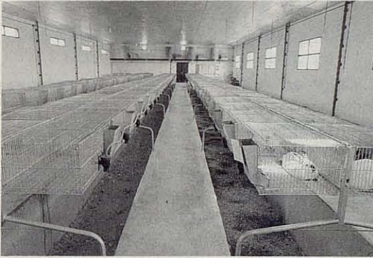
Granja de nueva construcción en sistema flat-deck y fosa profunda.
