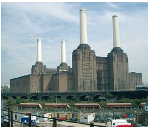
Central tèrmica a Clapham-Junction. Londres
