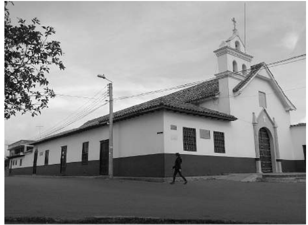
Figura 13: Construcción en tapia pisada y madera Fuente: Archivo Fundación Tierra Viva, Barichara, Colombia
