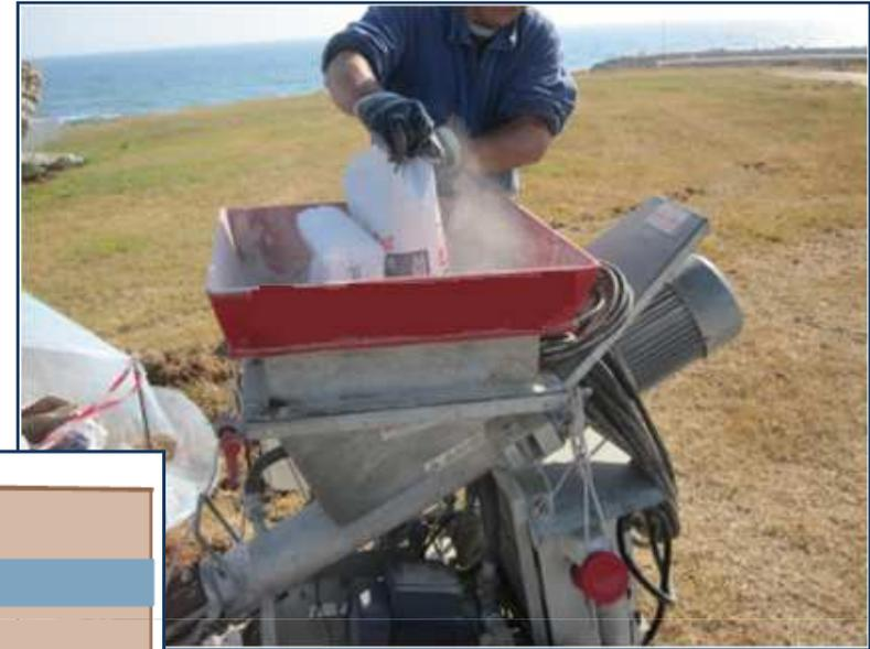
Per realizzare una cementazione che eviti la connessione tra diverse falde, è necessaria una corretta tecnica di cementazione ed un adeguato prodotto cementante
