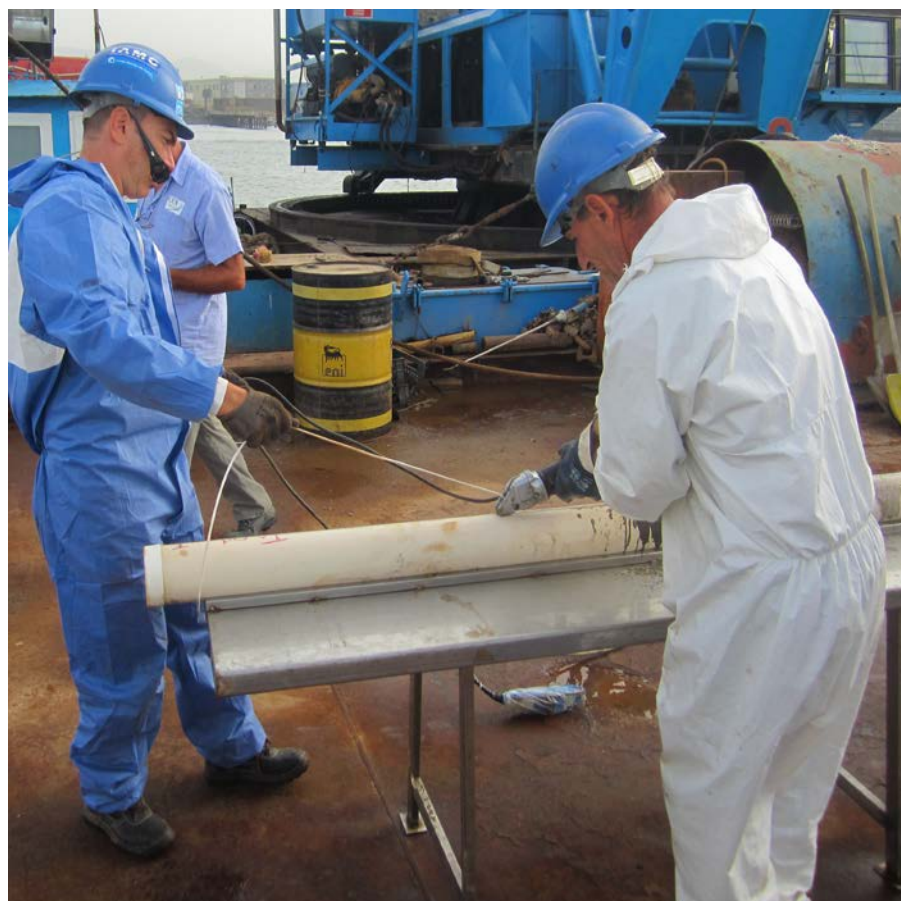
Figura 7.3 Fase di taglio del liner
