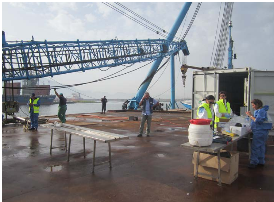
Figura 7.2 Allestimento cantiere con Geo-core 3000 e laboratorio mobile
