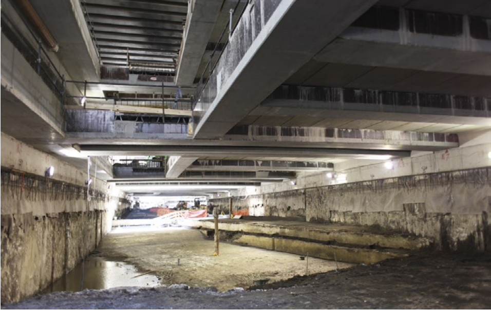
Fig. 3 – L'immagine ben rappresenta l'atipicità dello scavo e della documentazione grafica effettuata sotto copertura e durante la costruzione delle infrastrutture. Da notare l'illuminazione completamente artificiale.
