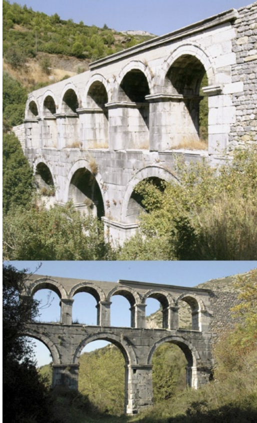
Fig. 7 – Due vedute del ponte-acquedotto di C. Sextilius Pollio , a Efeso (da WIPLINGER 2006).
