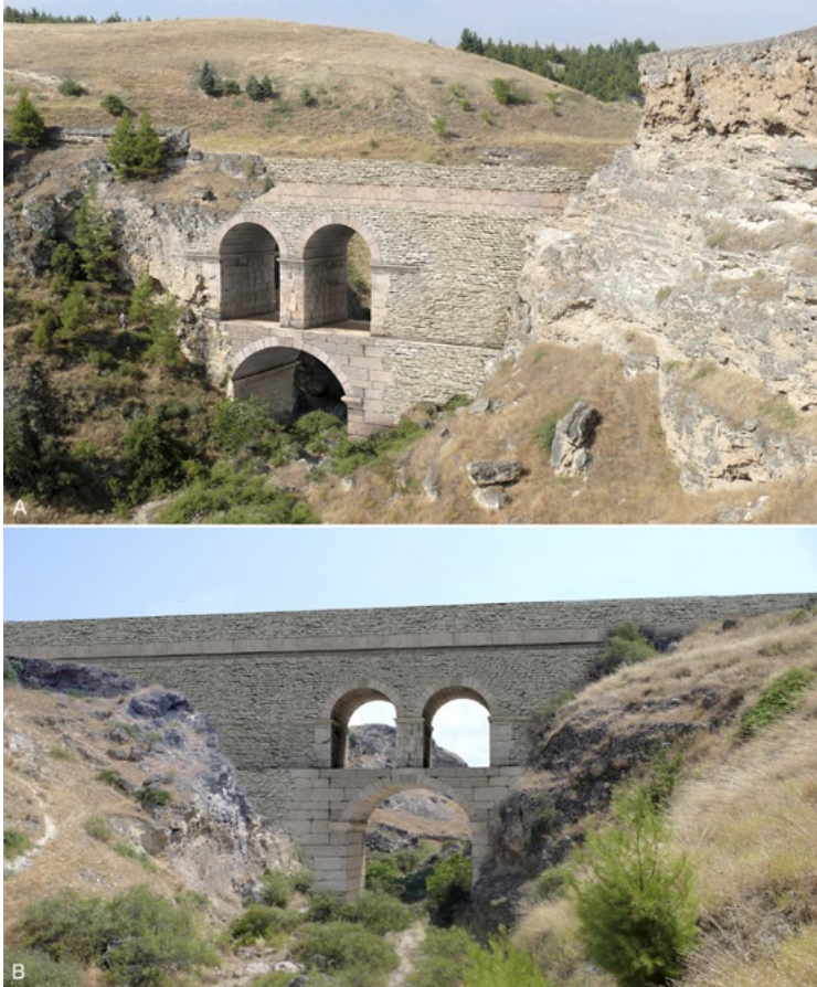
Fig. 9 – Vedute virtuali del Ponte Sud da E: ricostruzione della sola parte crollata (A) e anche di quella oggi coperta dalle concrezioni calcaree (B).
