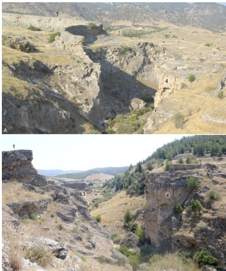
Fig. 3 – I resti del Ponte Sud visti da SO (A) e da NO (B): 1, formazione di calcare; 2, muro d'ala; 3, spalla settentrionale; 4, spalla meridionale.
