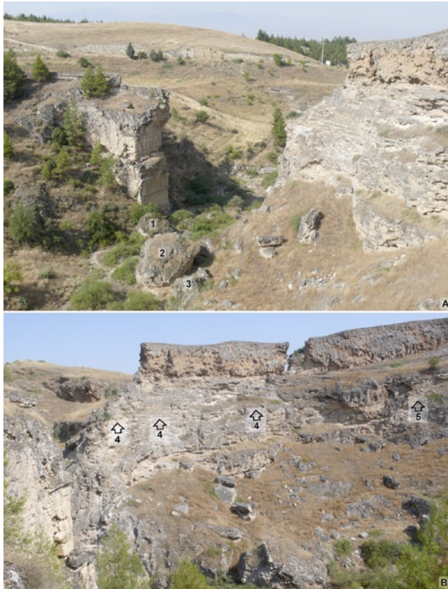
Fig. 4 – I resti del Ponte Sud visti da NE (A) e SE (B): 1-3, porzioni delle arcate e della spalla N crollati nell'alveo del corso d'acqua; 4, tratti del lastricato stradale a monte del ponte inglobati nel calcare; 5, muro di sostruzione della strada.
