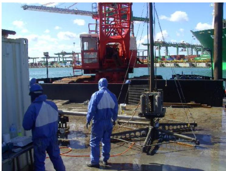
*Foto 2 – Vibro carotiere Geo-core 3000 con carotiere da 3 metri.*
