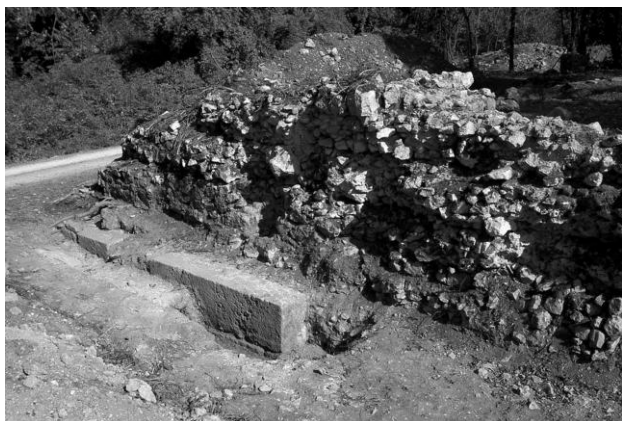
Fig. 14. Veduta del muro nord del podio con i resti del paramento in opera quadrata.
