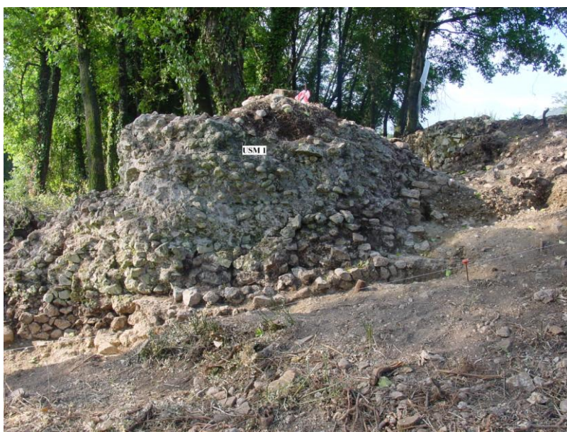
Fig. 3. Muro di testata nord del criptoportico.
