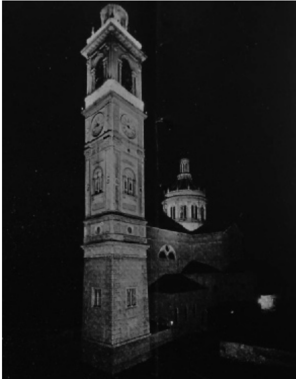
Fig. 4 - Il Duomo di Magenta illuminato con validi criteri illuminotecnici. Il gioco delle ombre consente di evidenziare i volumi, mentre le differenti intensità luminose manifestano le gerarchie degli elementi architettonici ( L'illuminazione alla fiera di Milano , "Illuminotecnica", n. 4, aprile 1929, p. 11)
