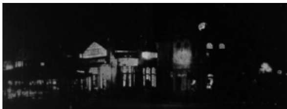
Fig. 10 - L'illuminazione dei padiglioni della Fiera di Milano è mediocre sia per la quantità di apparecchi, sia per la qualità dell'illuminazione. L'effetto risulta quello delle comuni vie cittadine con apparecchi sospesi non schermati né direzionati. (E. Castaldi, L'illuminazione con proiettori , "ILLUMINOTECNICA", n. 4, aprile 1930, p. 15)
