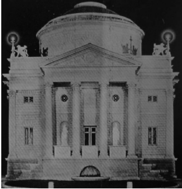
Fig. 3 - Esempio di illuminazione con proiettori a fasci incrociati del tempio voltiano a Como. Le ombre spariscono o si sdoppiano, facendo perdere la plasticità dell'opera. (E. Castaldi, L'illuminazione con proiettori , "Illuminotecnica", n. 4 aprile 1930)
