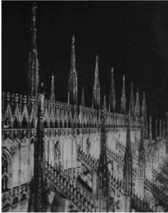
Fig. 6 - Particolare della fiancata del Duomo di Milano con l'illuminazione a proiettori della sola porzione superiore. (E. Castaldi, L'illuminazione con proiettori , "Illuminotecnica", n. 4 aprile 1930)
