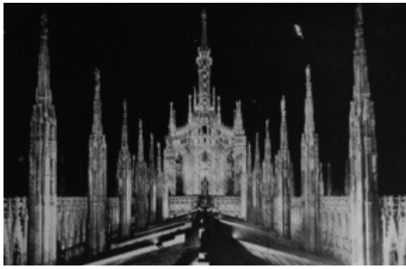
Fig. 5 - Particolare della copertura del Duomo di Milano con l'illuminazione a proiettori per una potenza totale di 200 kw. (E. Castaldi, L'illuminazione con proiettori , "Illuminotecnica", n. 4 aprile 1930)
