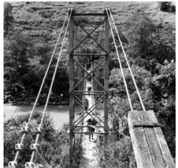
Fig. 12 - Ponte sulla Bhothe Kosi nel Nepal occidentale
