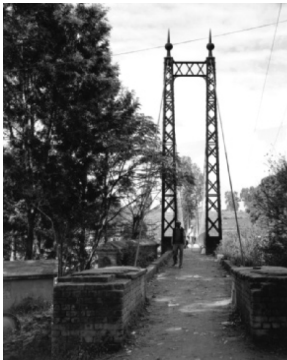
Fig. 6 - Ponte sulla Bagmati tra le città di Kirtipur e Patan
