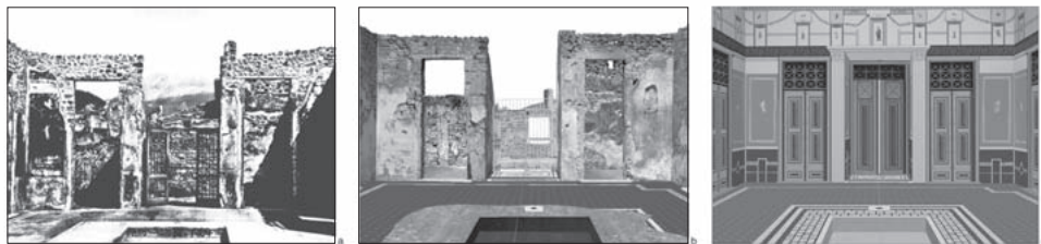
Fig. 4 – La parete settentrionale dell’atrio in una foto d’archivio (a), nel modello virtuale della situazione attuale (b), nella ricostruzione virtuale (c) (elaborazione grafica: E. Vecchietti).
