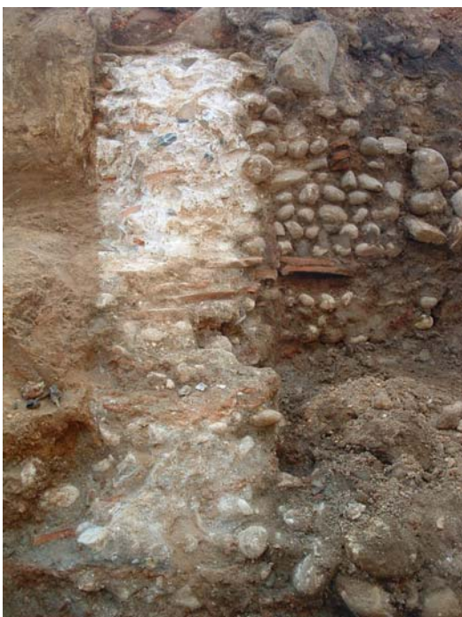
Fig. 3. Particolare della muratura della cisterna.
