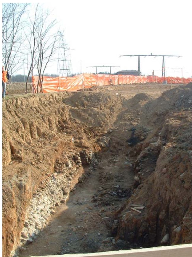
Fig. 1. I resti della cisterna nella trincea del collettore al momento dell'intervento.
