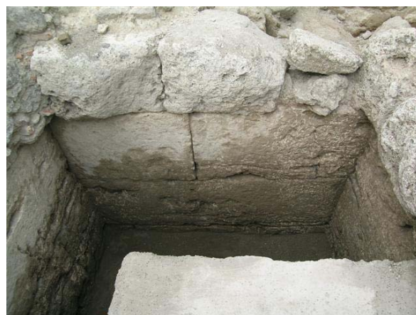
Fig. 11. Pozzo pubblico IX,2,1, particolare della parte terminale della canna in opera quadrata a brocchi di travertino.
