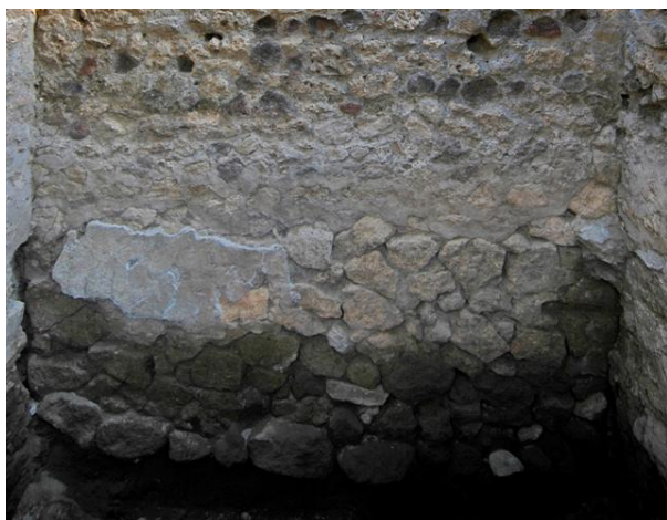
Fig. 5. Edificio VI,2,18-19: muro con paramento in poligonale riutilizzato come fondazione del successivo muro d'età tardo-sannitica.
