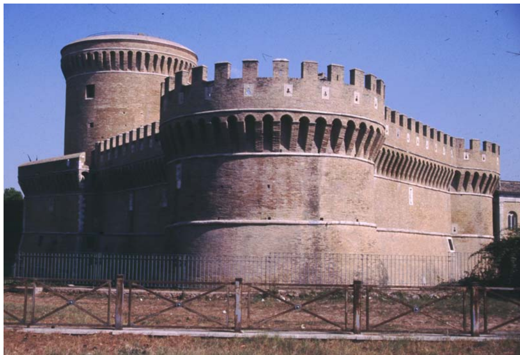
Fig. 1. Castello di Ostia Antica: veduta esterna da sud-ovest (foto F.Mapelli, © Archivio fotografico SBAO).
