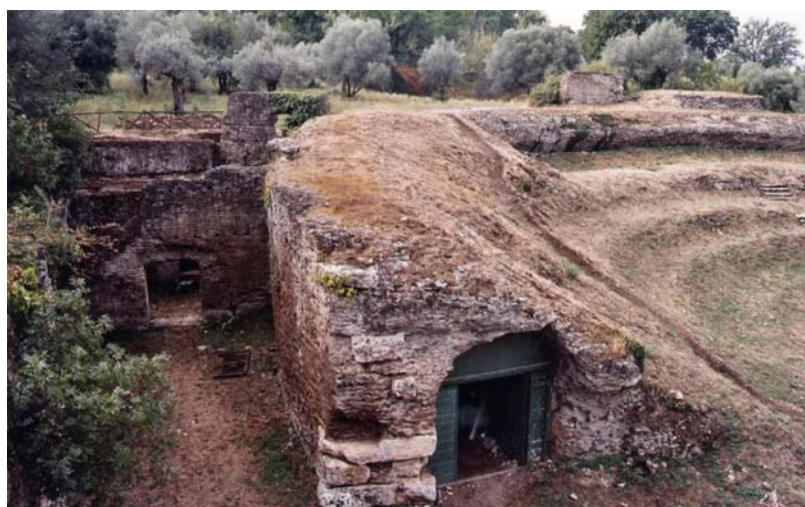
Fig. 2. Villa Adriana, Teatro Greco. Galeria-anular.
