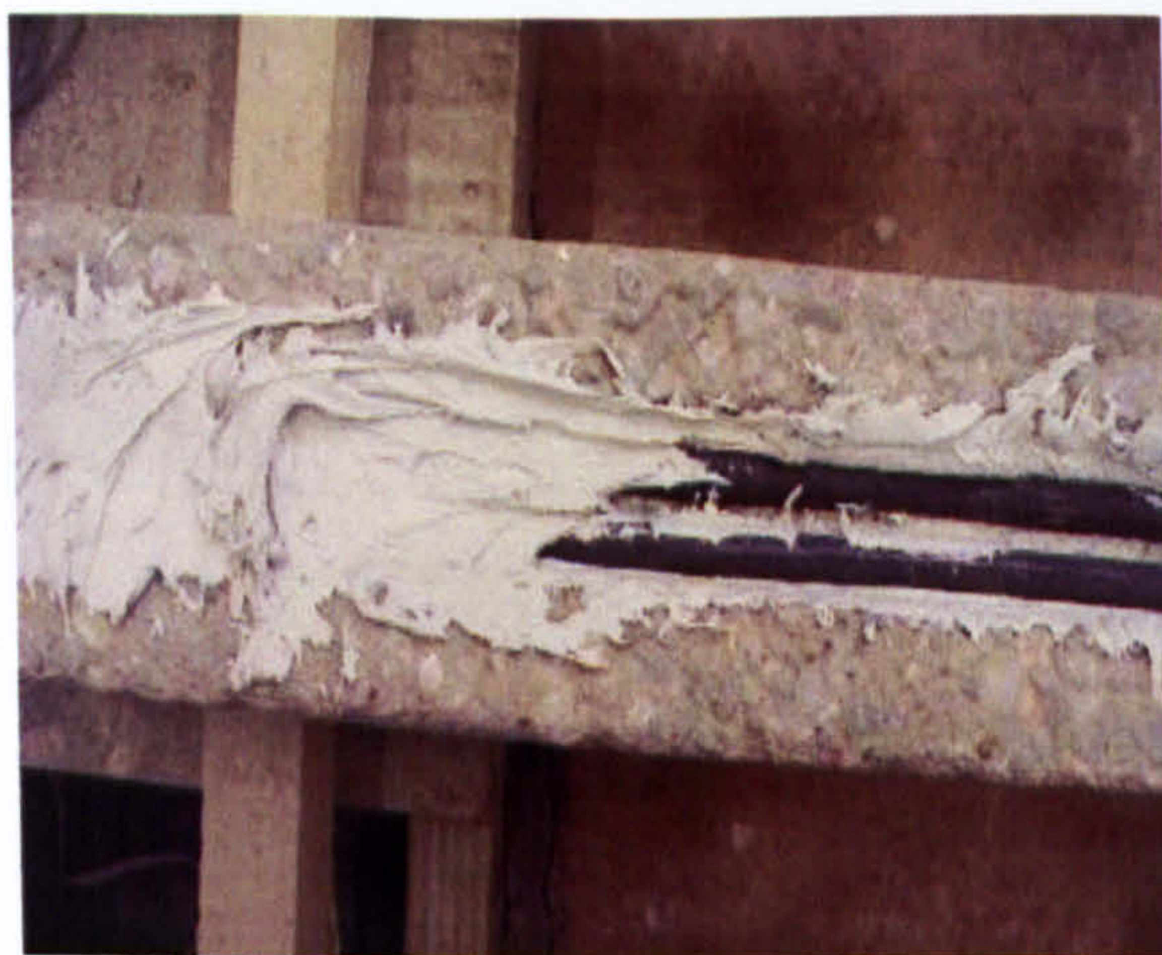
(d) Pour the remaining epoxy
