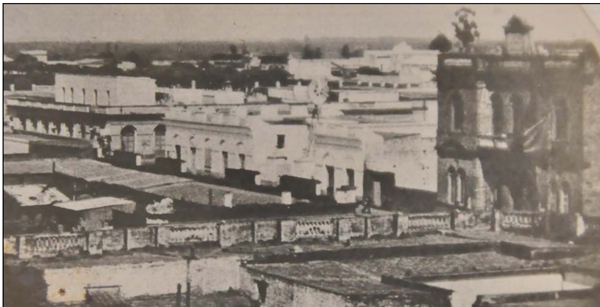
Vista superior fachada, desde azotea manzana al E.
