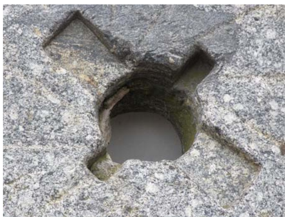
Figura 6. Impronta de lavija. Extremos en forma de cruz.
