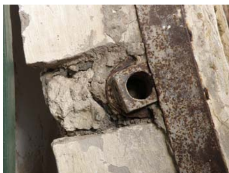
Figura 13. Muela N° 4. Orificio para alojar la cabria.
