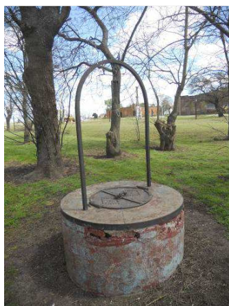
Figura 53. Pozo N° 7. Gardey.
