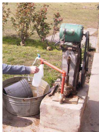
Figura 52. Pozo N° 4. Gardey.
