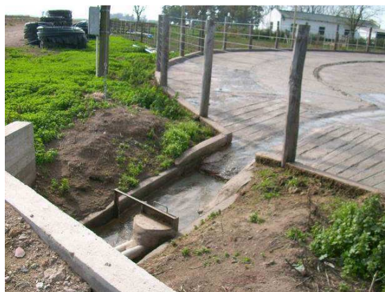
Figura 69. Salida de efluentes desde el corral hacia la cava (Sitio N° 5)
