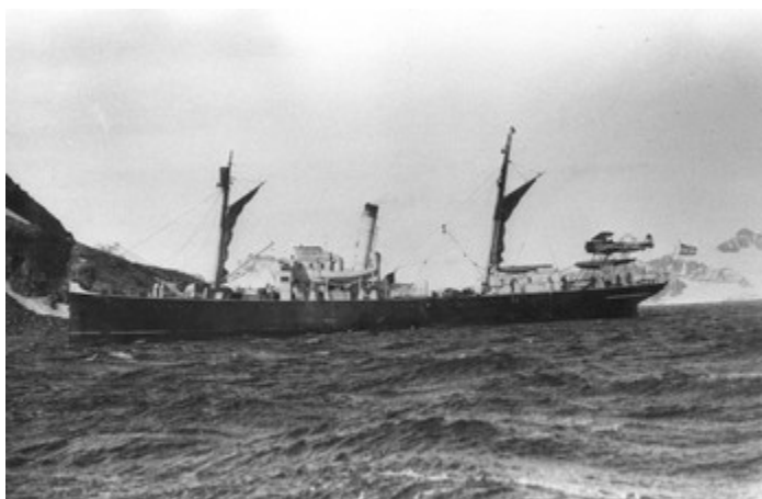
El Primero de Mayo en la ría Nancy de Bahía Margarita, en el Círculo Polar, 1943. Se aprecia el Nido de Cuervo en el Trinquete, el aparejo Goleta con sus cangrejas aferradas y el Stearman E 42 trincado en popa.
