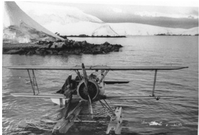
Expedición 1943. Poniendo en marcha el motor del avión para realizar un vuelo de observación meteorológica en altura (temperatura, presión, humedad). Obsérvese el meteorólogo en el ala de estribor.
