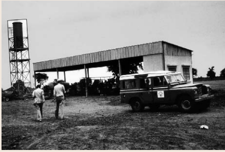
Construction et équipement de la SRAC. Garage et château d'eau. 1983
