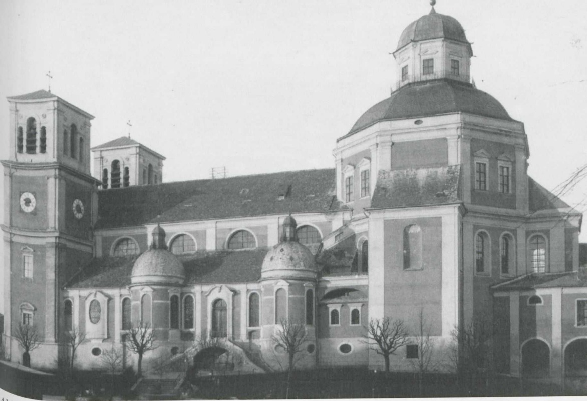
Abb. 13: Kempten, ehem. Stiftskirche St. Lorenz, Ansicht von Süden, historische Aufnahme vor dem 1895 erfolgten Ausbau der Türme. Foto: Staatliches Hochbauamt Kempten.
