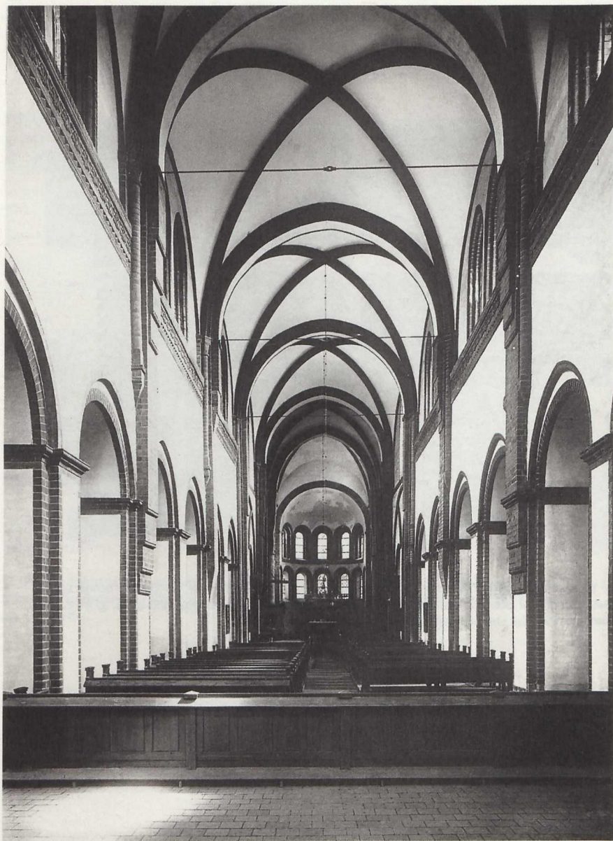
21 Innenansicht der ehem. Zisterzienserklösterkirche Lehnin nach Osten, Zustand nach der Restaurierung mit Blick auf die für die Monumentalmalerei vorgesehenen Wandflächen über den Arkaden, Bildarchiv Foto Marburg, Archivnummer 12.443
