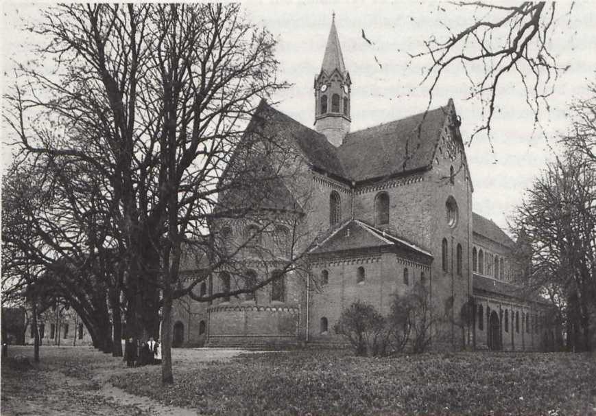
18 Außenansicht der ehem. Zisterzienserklosterkirche Lehnin nach der Restaurierung von Osten, Photographie um 1900, Meßbildarchiv, Brandenburgisches Landesamt für Denkmalpflege und archäologisches Landesmuseum, 61t 32/3050.1a
