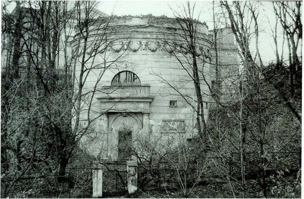
4. Warszawa, budynek kuchni w Królikarni. Fot. P. Jaworski, 2002
