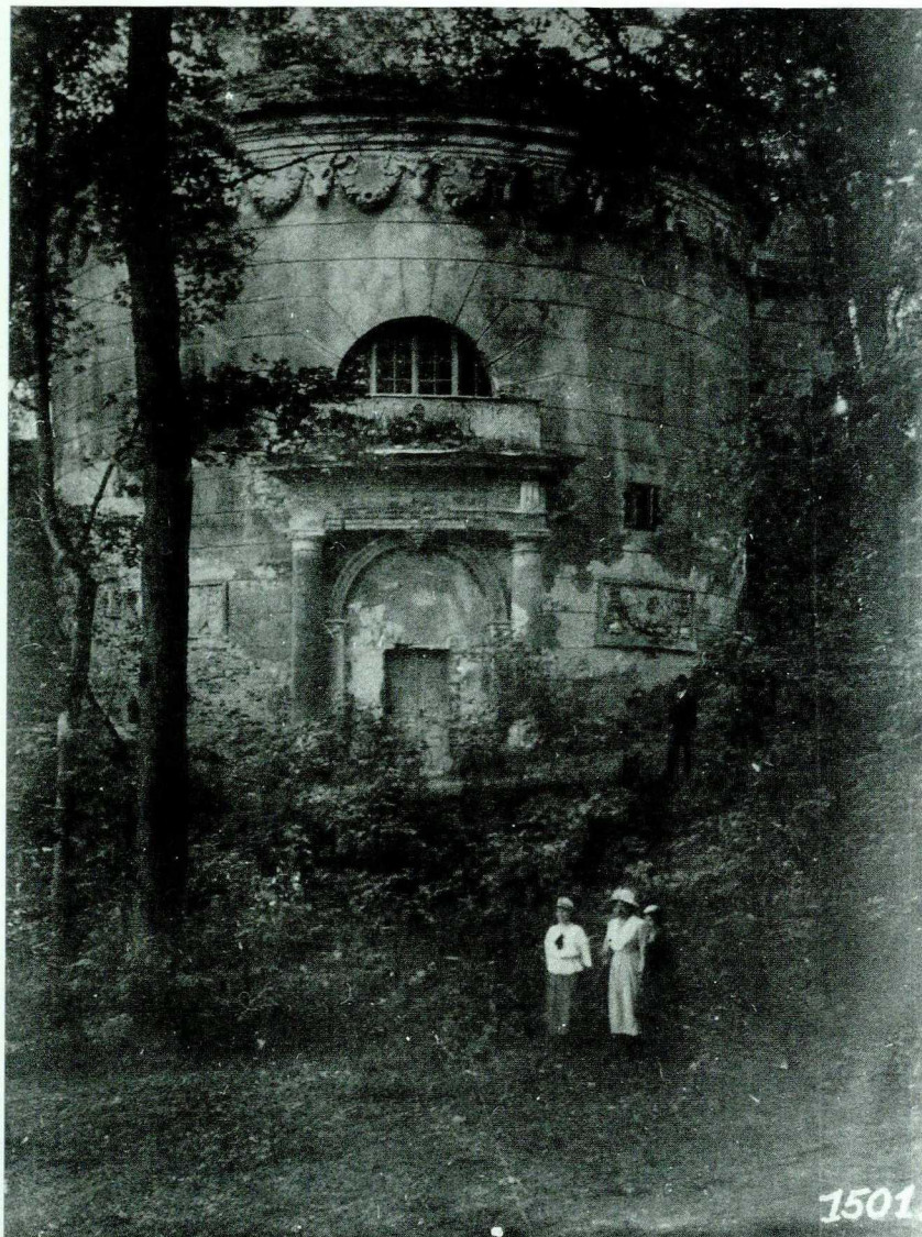
10. Warszawa, budynek kuchni w Królikarni. Stan z początku XX w. Fot. J. Kłos (IS PAN)
