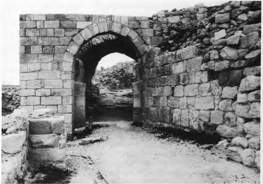
Abb. 4: Montréal/Shobaq, Torbau des umlaufenden Zwingers, Außenseite von Osten. (Foto: Th. Biller, 1998)
