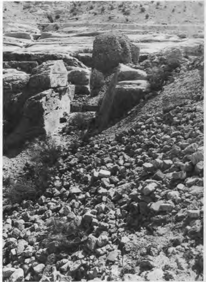
Abb. 8: Li Vaux Moïse, der Nordgraben von der Stelle des ehemaligen Nordwestturms aus; vorne der Felssockel des zerstörten Mittelturmes, dahinter der Stumpf des Nordostturmes. (Foto: Th. Biller, 1998)
