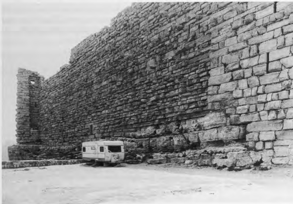
Abb. 13: Kerak, »Schildmauer« gegen die Stadt. Im Vordergrund der aufgefüllte, ehemals etwa 30 m tiefe Graben. (Foto: Th. Biller, 1998)
