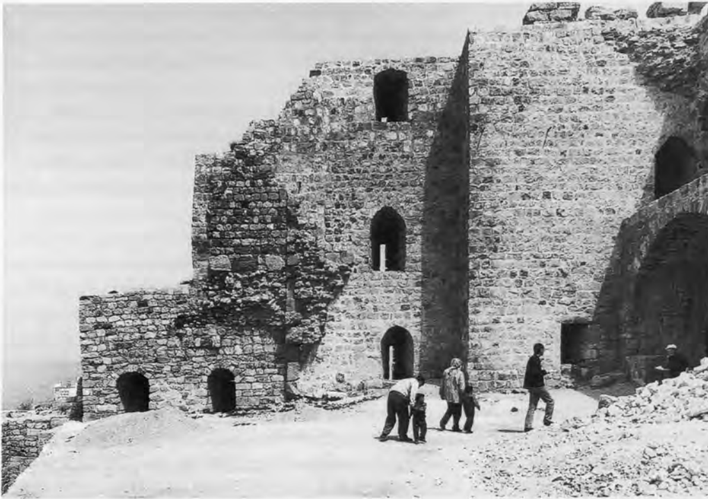
Abb. 14: Kerak, Spuren des älteren nordwestlichen Eckturmes in der Innenseite der stadtseitigen «Schildmauer», von Süden. Nach Restaurierung ist links noch die Quaderverkleidung der Westwand im Schnitt zu erkennen. Die drei restaurierten Schießscharten übereinander lagen in der Grabenwand des Turmes, der Mauerversprung rechts davon ist der verfälscht restaurierte Ansatz der TurmOstwand. Ganz rechts die restaurierte Öffnung der beiden Hallen hinter der jüngeren Schildmauer. (Foto: Th. Biller, 1998)
