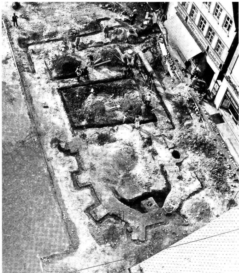
Freilegung der Grundmauern der Veitskapelle im Jahre 1972
