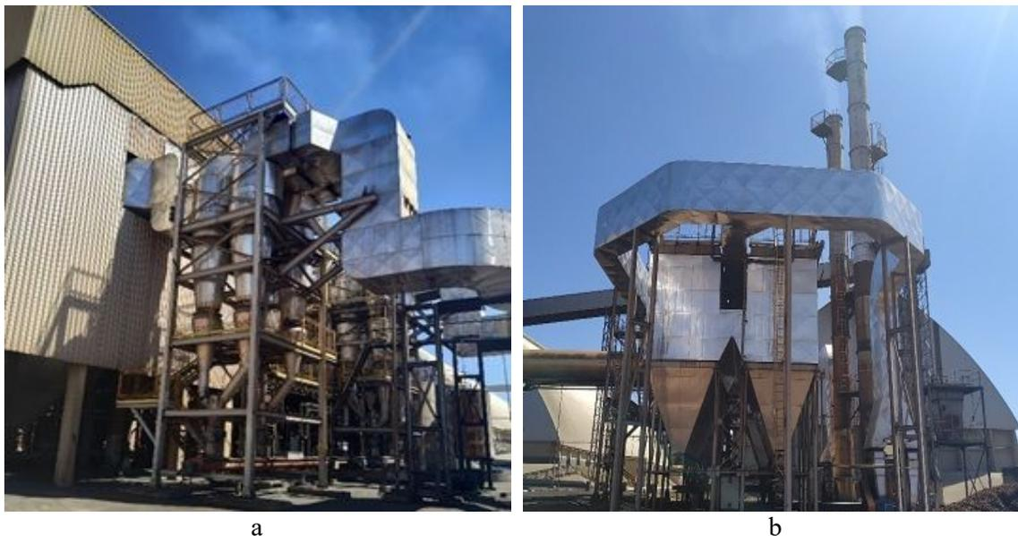
**Figura 2:** Conjuntos de multiciclones (a) e Conjunto de filtros de manga (b)
